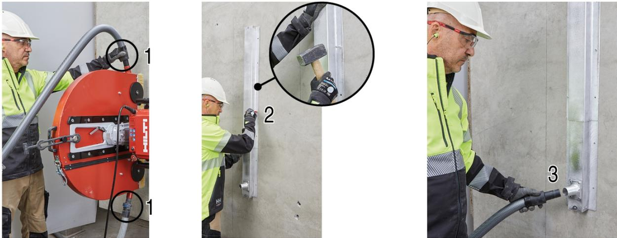
1. Montieren Sie den BG 65 Blattschutz (Trockenschnitt).
