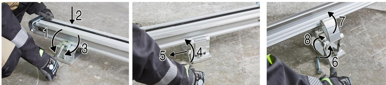
4. Setzen Sie die Schiene auf die Schienenfüße.
